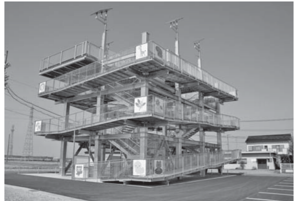
浅羽南地区に設置された津波避難タワー
