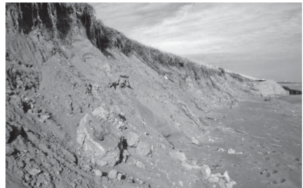
台風の来襲で崩れた浅羽海岸の防潮堤
