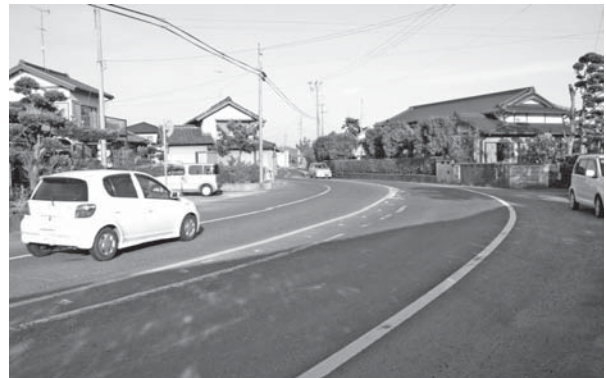
改良工事が望まれる県道磐田掛川線
