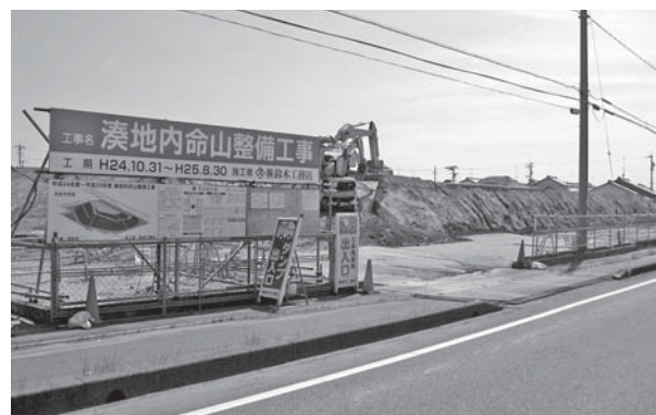
湊命山の整備工事
