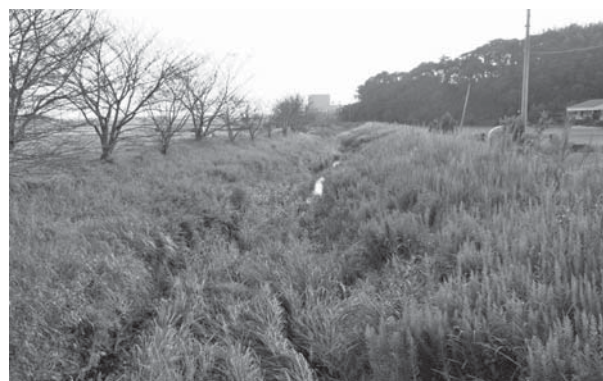
鼻脇橋付近の堤防
