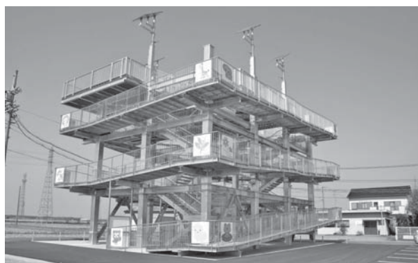
津波避難施設「きらりんタワー」
