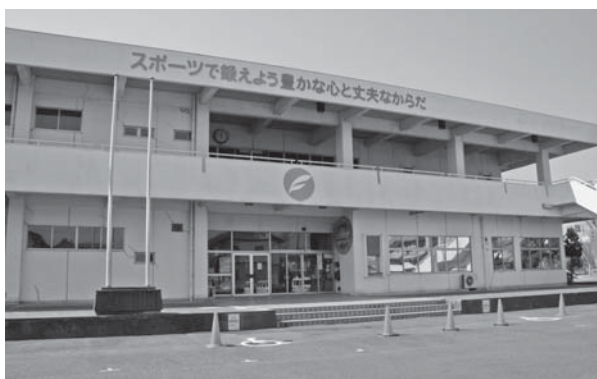
建設から40年経過した袋井市民体育館
