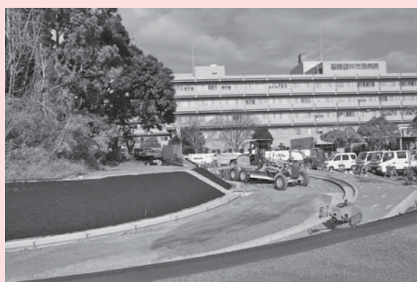
整備中の南側進入路（平成26年1月完成）
