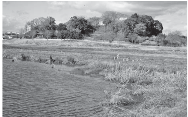
建設が進められる久野城址南遊水池
