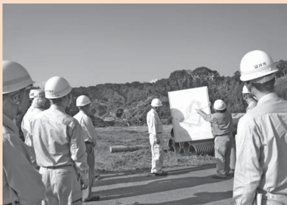
下野辺工業団地における現場説明
