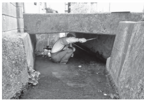
近接目視による橋梁点検
