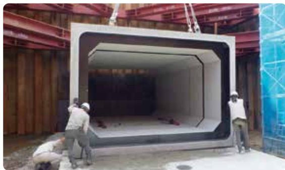
柳原雨水ポンプ場整備状況(放流渠)
