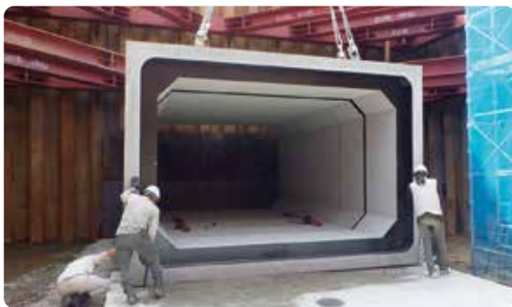
柳原雨水ポンプ場整備状況(放流渠)
