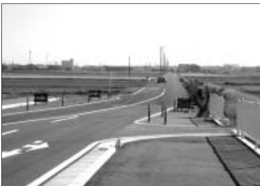
工事未着手の江ノ端から東同笠までの道路
