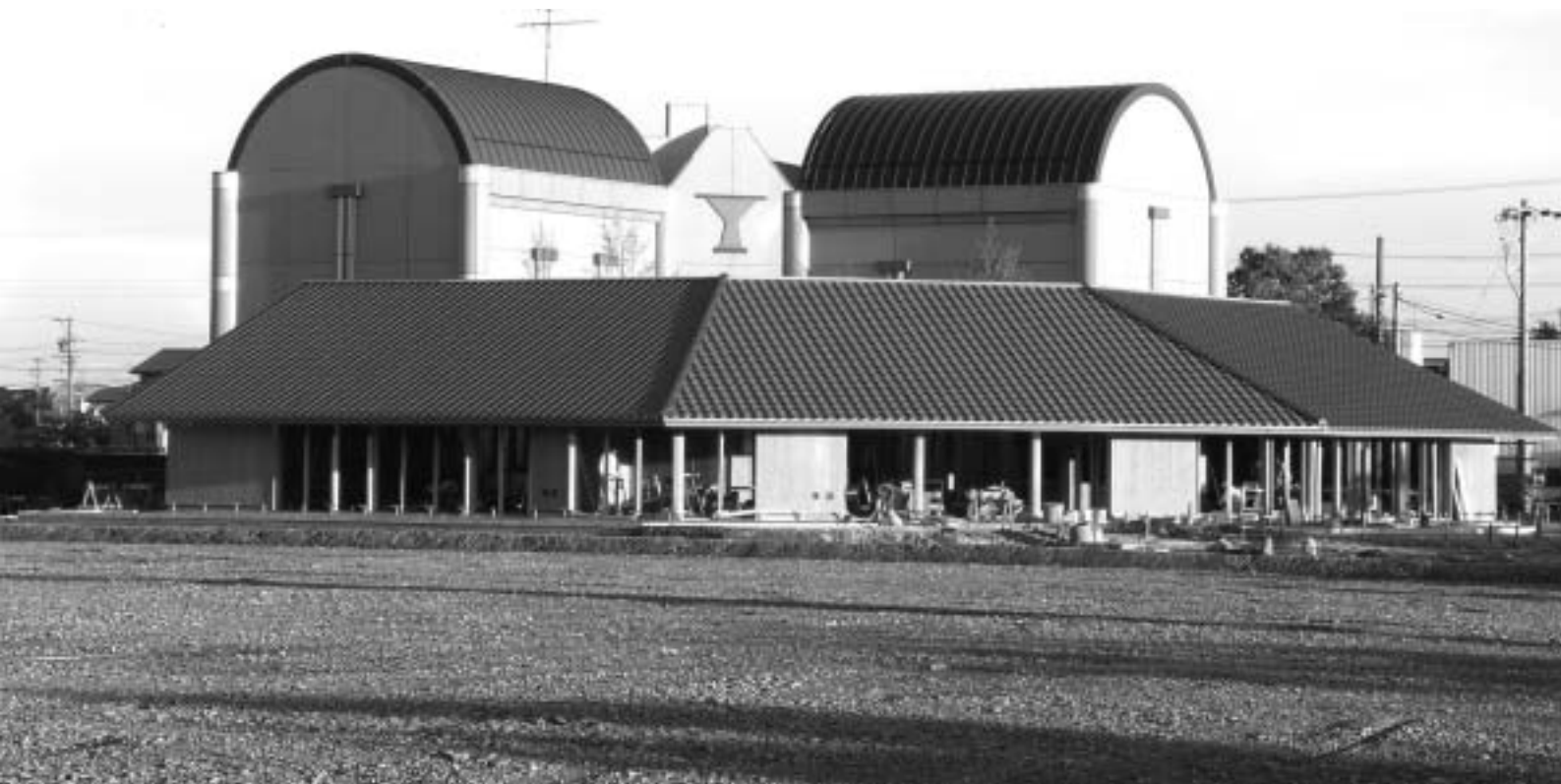
建設が進む近藤記念館
