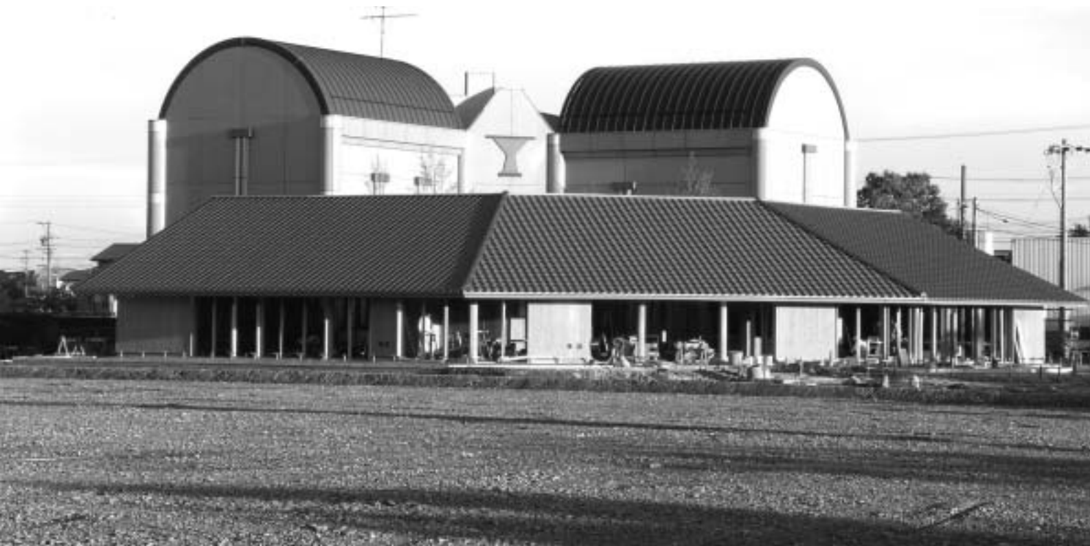
建設が進む近藤記念館
