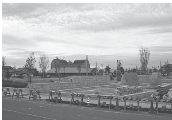
浅羽記念公園工事現場
