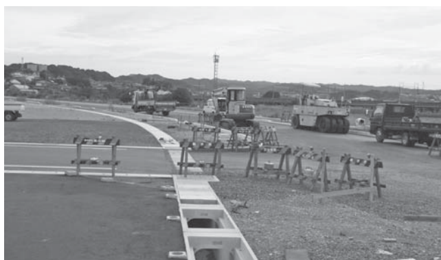
都市計画道路・駅南循環線の工事現場
