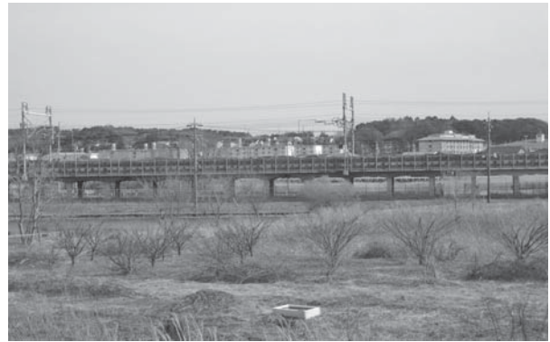
治水対策の必要性がある駅南地区
