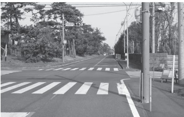
道路のかさ上げが希望される湊中新田浜道線（同笠海岸交差点）
