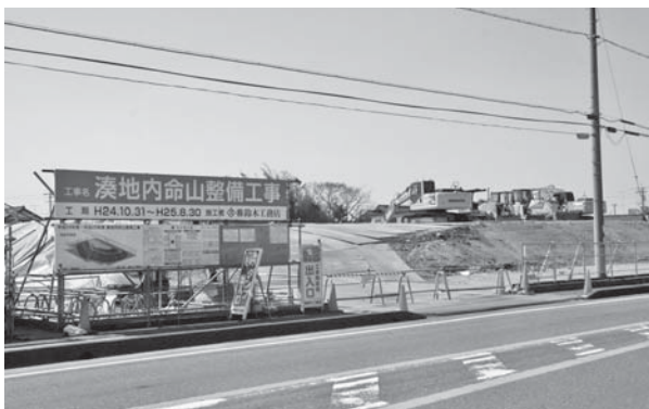
建設中の湊地内命山
