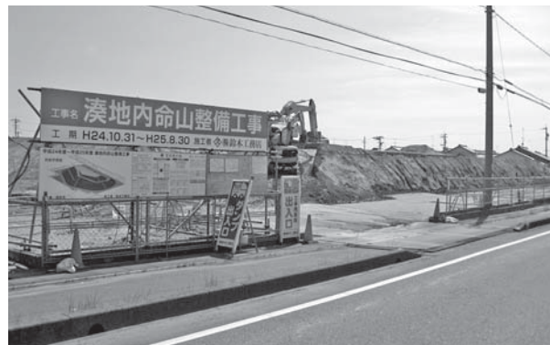
湊命山の整備工事
