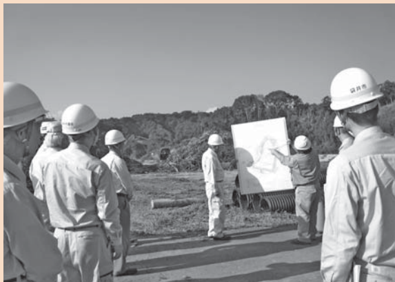
下野辺工業団地における現場説明
