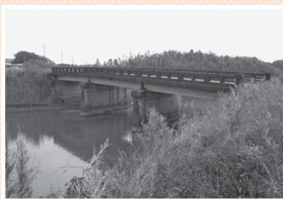
昭和39年3月竣工の広瀬橋
