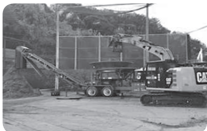
草木・剪定枝の処分の様子
