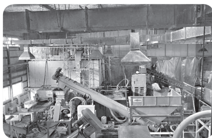
食品残渣を利用したバイオマス発電
