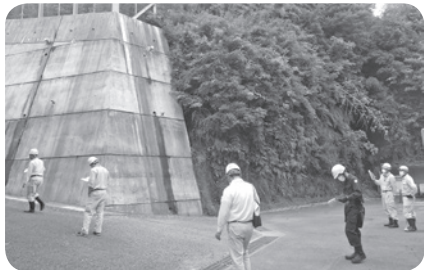
施工済箇所の現場確認
