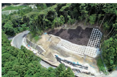
令和5年度より進めている市道大谷幕ヶ谷線災害復旧工事施工箇所の様子（令和6年7月3日撮影）
