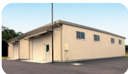
備蓄品を収納している市防災倉庫(豊沢)
