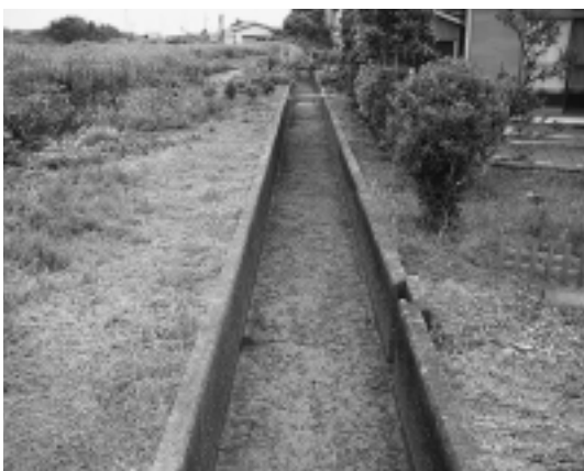
富里下地内の磐田用水路跡地
