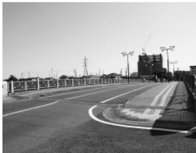
補正予算で耐震補強を行う「和橋」
