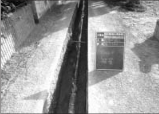
水需要にこたえるための配管の布設替え
