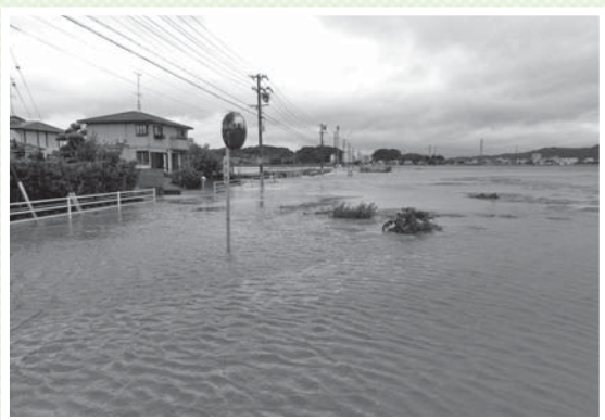
台風18号による浸水被害
