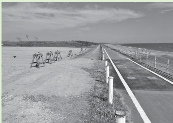
防潮堤の工事現場
