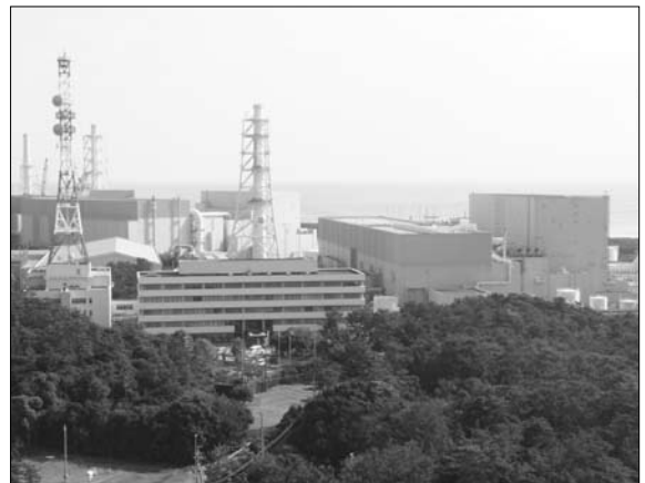
浜岡原子力発電所
