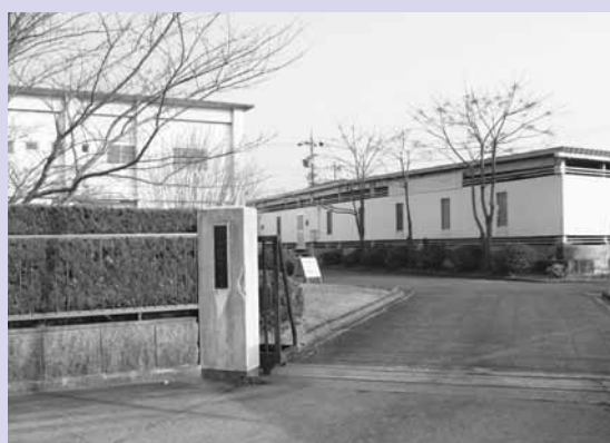
小川町浄化センター
