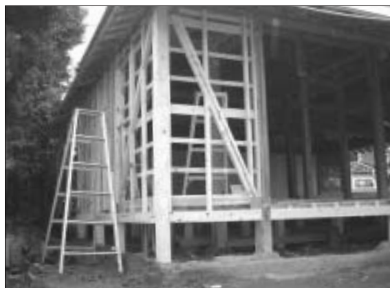
「筋交い」による耐震補強例
