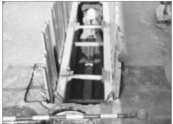
下水道管の布設工事
