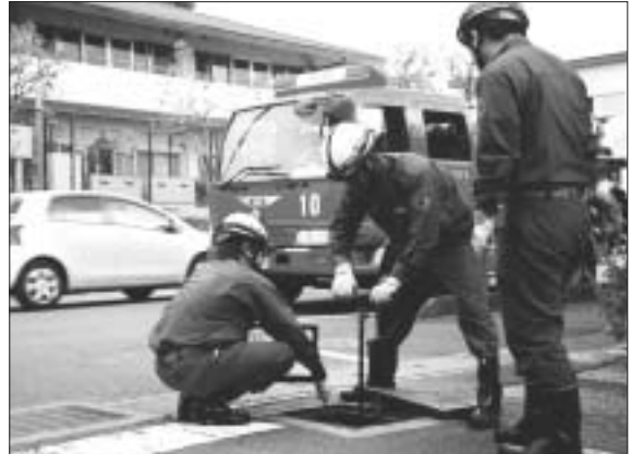
消防団による消火栓点検
