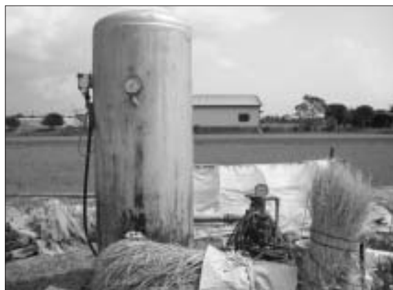
地下水汲み上げポンプ(井戸)
