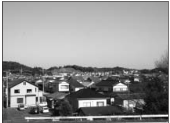
消防出張所の建設が望まれる北部地区
