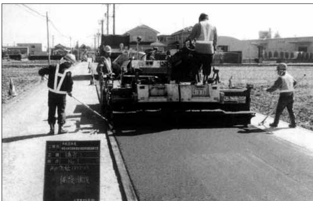
道路修繕工事の様子
