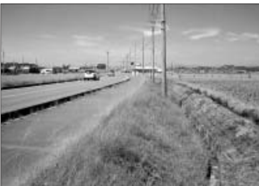
防護柵の設置が望まれる県道(浅羽中南側)
