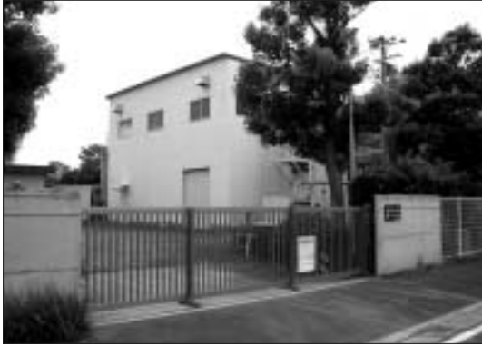
上水道第1水源地
