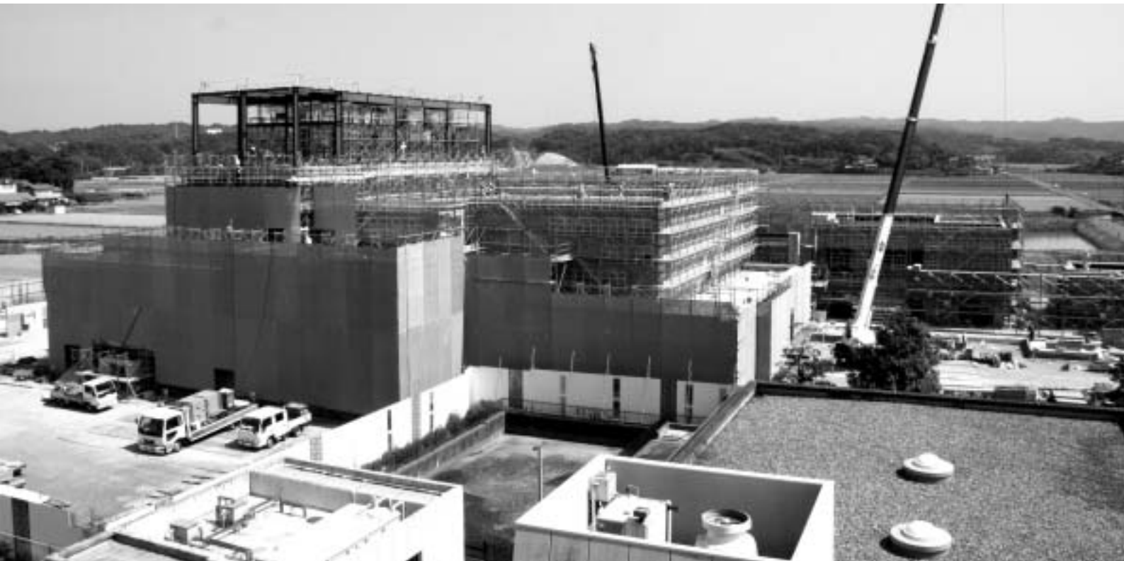
来年3月の完成に向けて工事が進むメロープラザ
