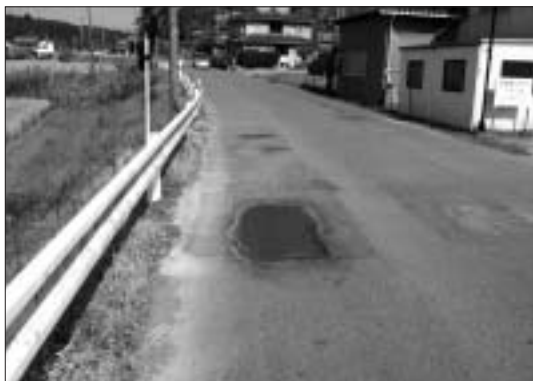
応急修繕された道路
