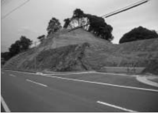
工事が進む大日ほたるの里公園
