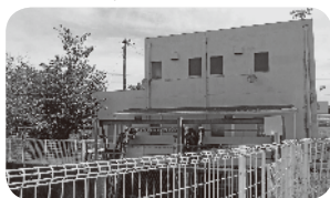
柳原排水機場
