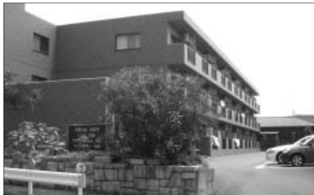
近隣市の小規模多機能型居宅施設
