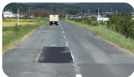
道路舗装維持修繕された市道(友永地内)
