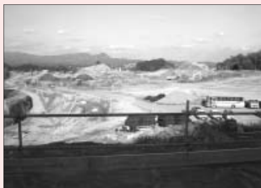
造成が進む新病院建設地
