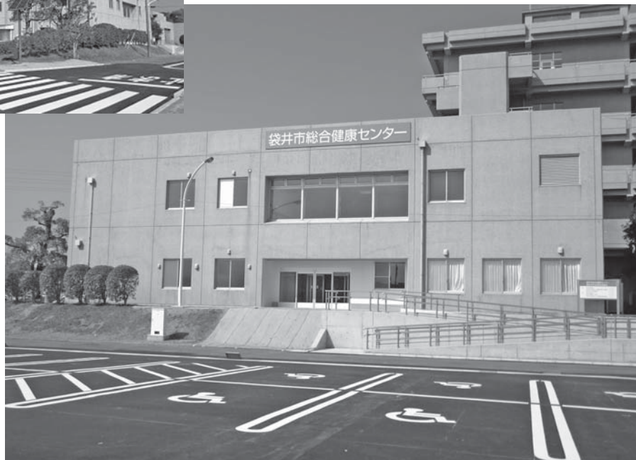
平成27年5月オープンの総合健康センター（東側に新設した玄関）
