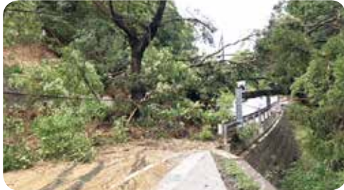
市道大谷幕ヶ谷線三川加圧ポンプ場西側法面崩落の様子
