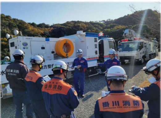
【写真2】県西部地区消防本部と 国土交通省の排水ポンプ車取扱訓練
