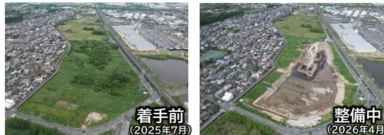
▲新幹線南側遊水池整備
