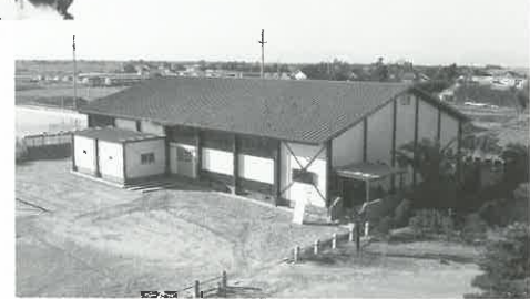
浅羽中学校格技場完成
