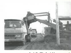
幸浦農免道の工事
