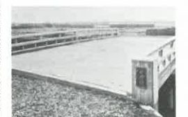
待望の新掘橋完成
