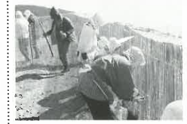
海岸の砂防工事進む
