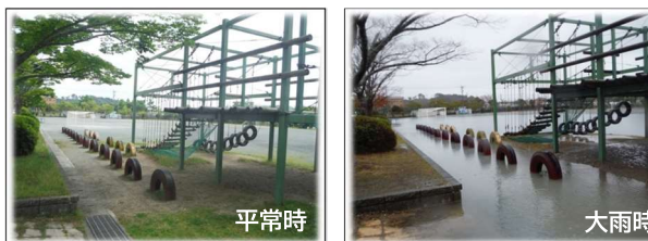
校庭貯留施設整備(高南小学校)
