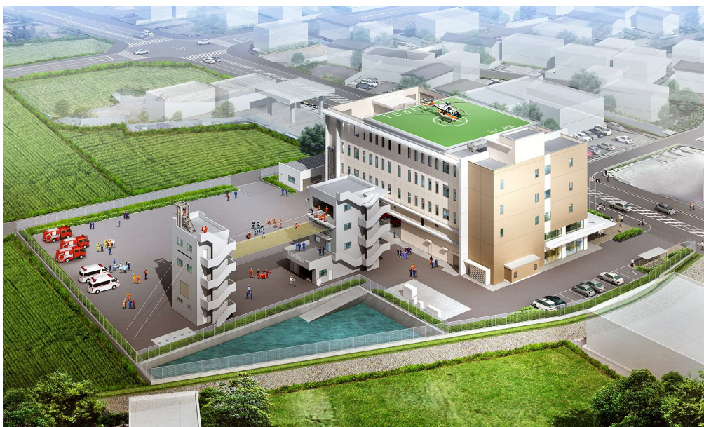
建設中の袋井消防庁舎・袋井市防災センター
