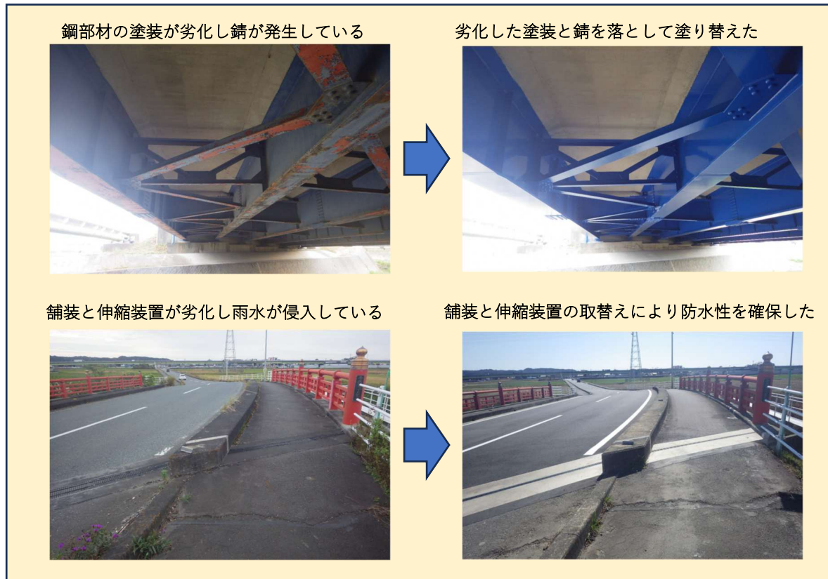
【図 8 修繕による劣化損傷の回復の例（瑠璃の橋）】
