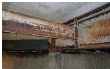
桁の腐食
