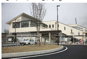
JR袋井駅南口 (橋上駅舎と南北自由通路)
