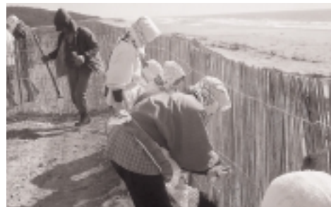
季節風による飛砂を利用するため竹すのこや粗朶を立てて防潮堤を築く海岸砂防工事(昭和45年)
