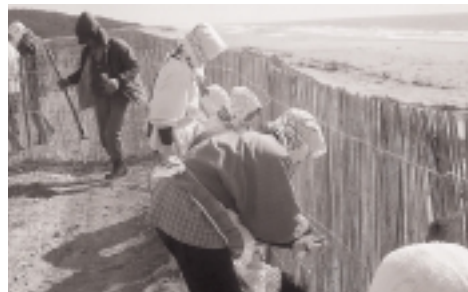
季節風による飛砂を利用するため竹すのこや粗朶を立てて防潮堤を築く海岸砂防工事(昭和45年)
