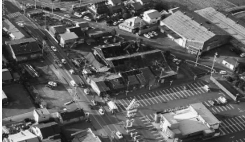
諸井地区を中心に突風被害発生(2月14日)
